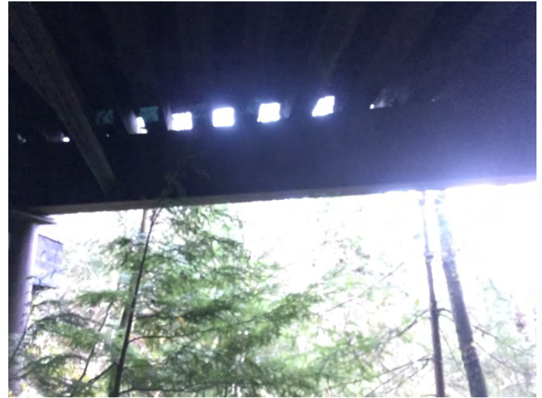
Left span flare girder
